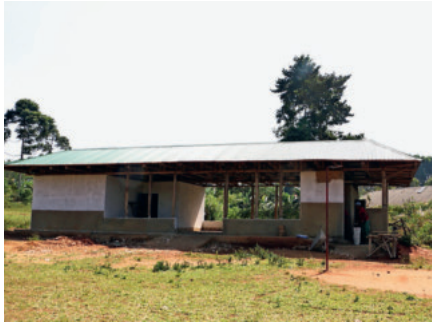
Das neue Clubhaus in Kasubikamu im Bau.
