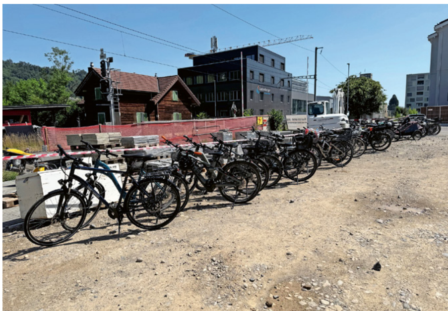
Das Mobilitätskonzept funktioniert auch am Tag der offenen Baustelle. Bild: Kurt Huber
