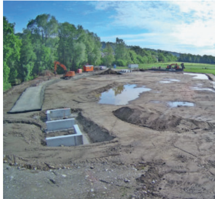
Die Arbeiten schreiten voran. Bild: zvg
