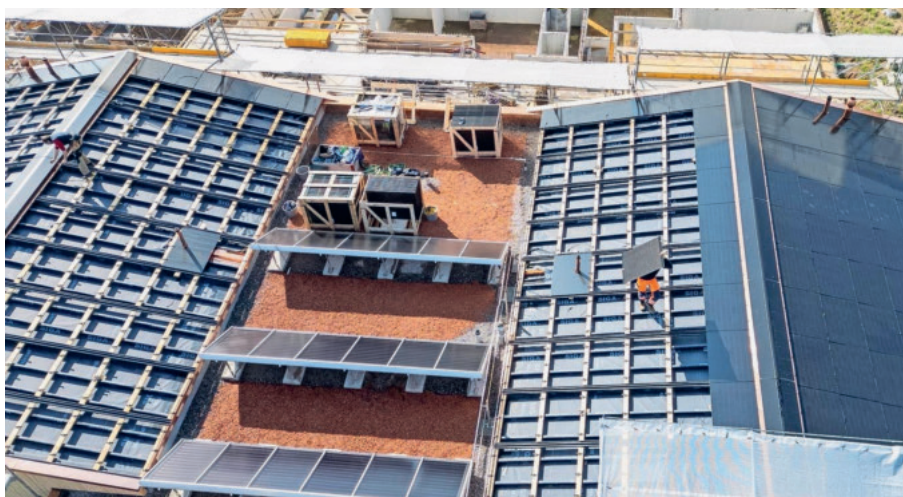
Die dachintegrierte PV-Anlage wird installiert. Bild: zvg
