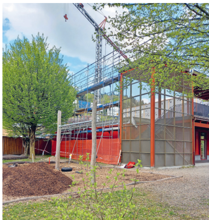
Der zusätzliche Eischachen-Kindergarten im Bau.
