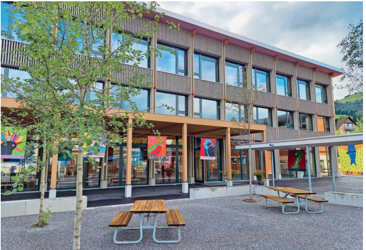
Der Neubau trakt des Schulhauses Muoshof
