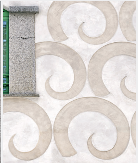
In sorgfältiger Handarbeit entsteht aus Putz ein Muster mit Geschichte: Mit dem Kratzeisen werden die geschwungenen Linien der Bockshörner von Hand ausgearbeitet (Bild links). Im fertigen Zustand zeigen sie ihre Ruhe und Präzision als Teil der Fassadengestaltung des Hauses «Mona» (Bild rechts). Fotos: Marcus May
