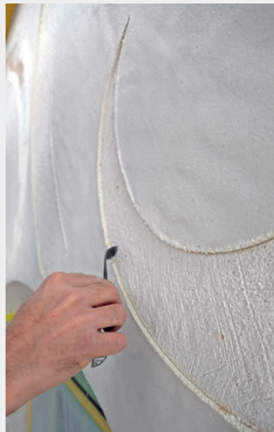
In sorgfältiger Handarbeit entsteht aus Putz ein Muster mit Geschichte: Mit dem Kratzeisen werden die geschwungenen Linien der Bockshörner von Hand ausgearbeitet (Bild links). Im fertigen Zustand zeigen sie ihre Ruhe und Präzision als Teil der Fassadengestaltung des Hauses «Mona» (Bild rechts). Fotos: Marcus May
