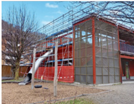
Baufortschritt Eischachen: 1. April 2025 ...
