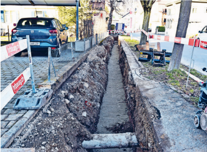
Das Restaurant Bahnhof und der Gemeindesaal werden an das Fernwärmenetz angeschlossen.
