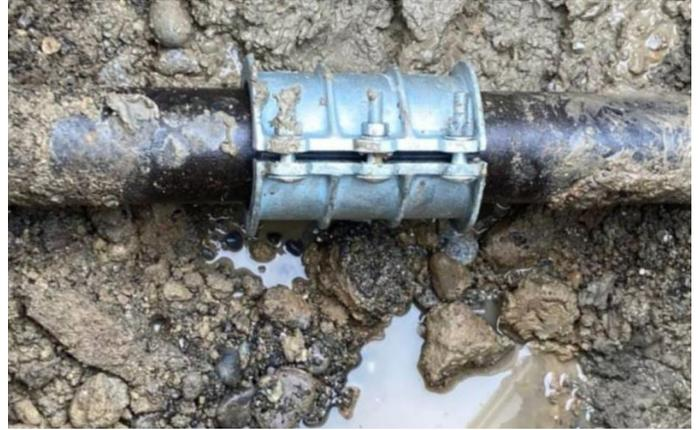
Für Leitungsreparaturen gelangen Bauteile zur Anwendung welche eine effiziente, rasche und sichere Reparatur ermöglichen
