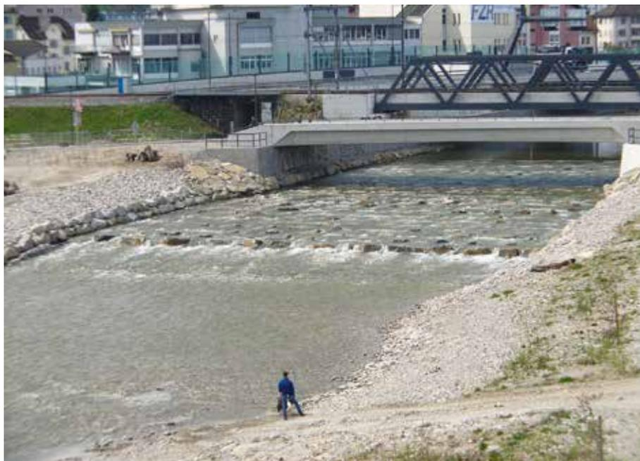
**Blockrampen, wie hier an einem Beispiel, werden auch an der Kleinen Emme gesetzt und das Ufer wird ebenso zugänglich**
