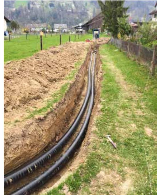
So dürfte es demnächst in Malters aussehen: Verlegung von Fernleitungen für eine nachhaltige und CO<sub>2</sub>-neutrale Wärmeversorgung
